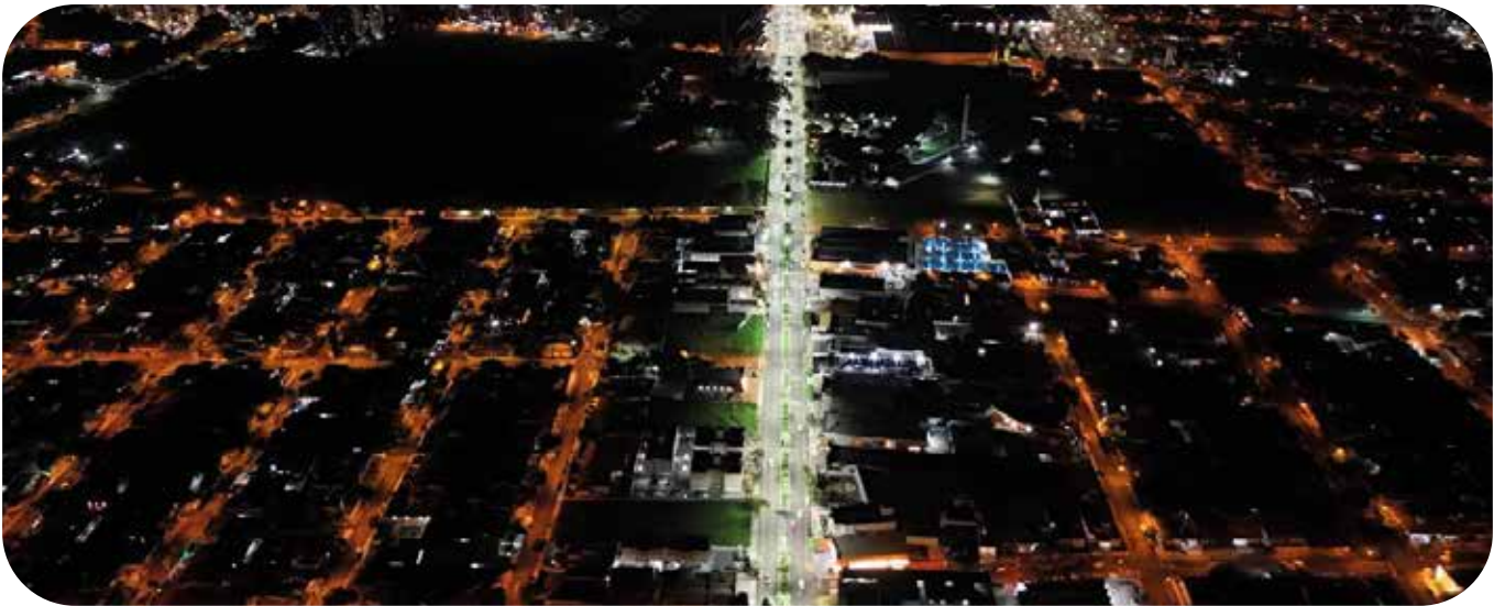
Iluminação da Av. Brigadeiro Faria Lima em S. J. do Rio Preto - SP
